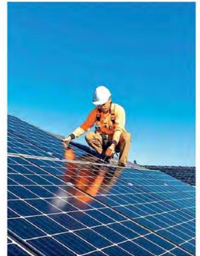
Un tecnico all'opera per installare un pannello fotovoltaico
