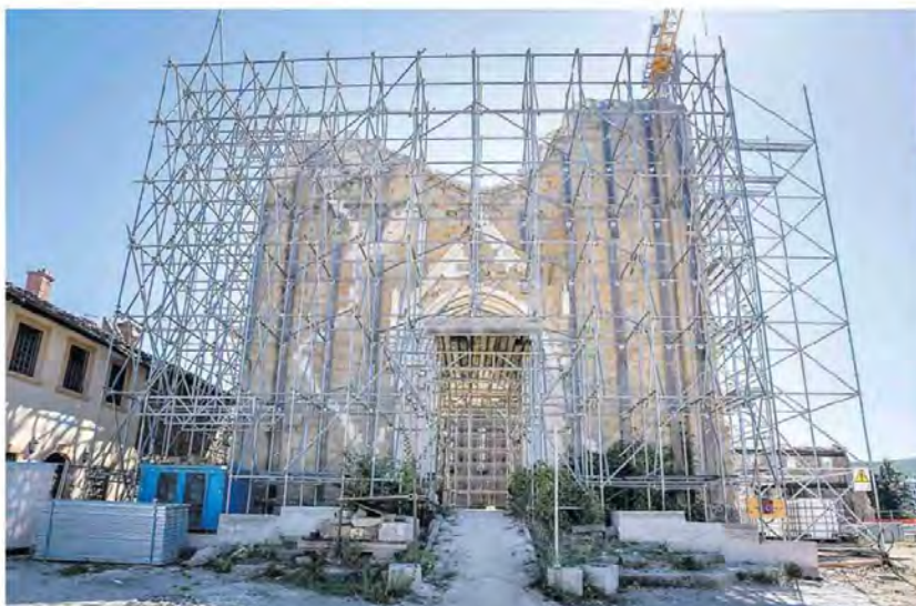
Il cantiere della ricostruzione della Chiesa di San Francesco ad Amatrice (foto FRACASSI/TOIATTI)
