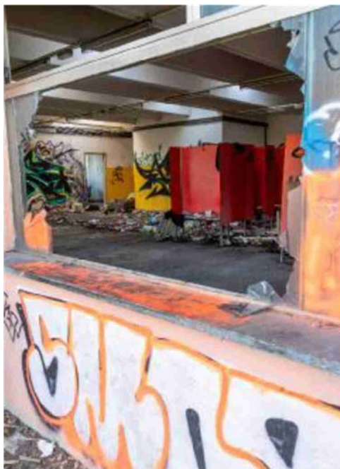
L'interno Uno dei locali abbandonati
