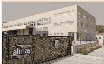
Esterno dello stabilimento
