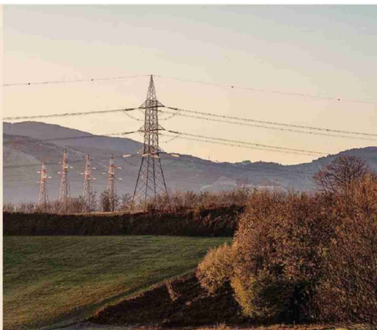
Rete elettrica. In un contesto di elettrificazione dei consumi, diventa fondamentale la concertazione tra soggetti che operano sulle reti
