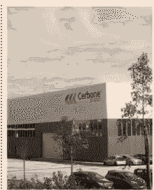
Esterno dello stabilimento
