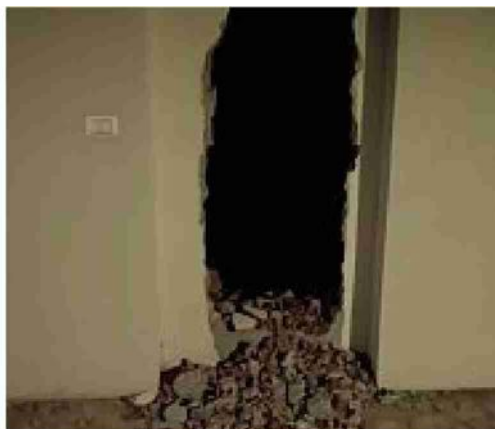
Abbattuto Il muro della casa del Villaggio dei Fiori
