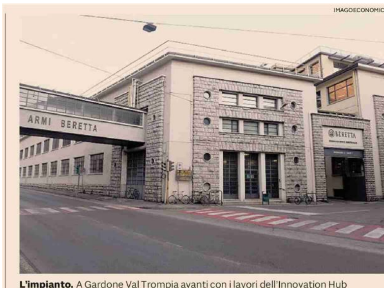
L'impianto. A Gardone Val Trompia avanti con i lavori dell'Innovation Hub
