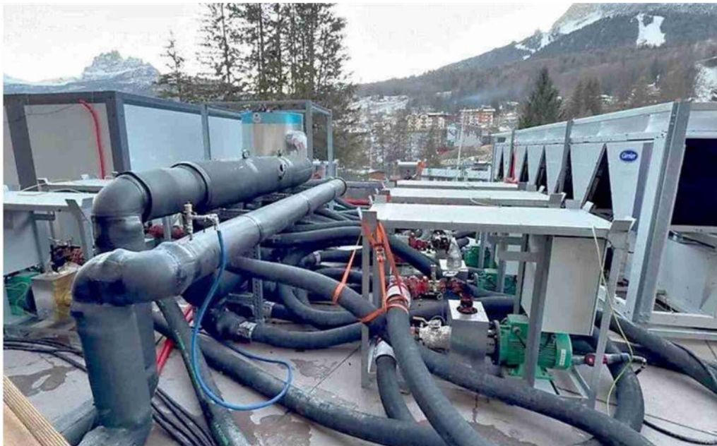
L'impianto di refrigerazione installato dalla ditta francese GL all'interno dello stadio del ghiaccio
