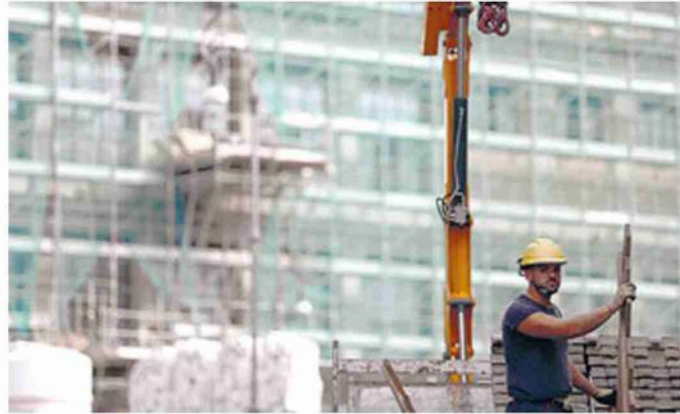
Cantiere edilizio a Roma foto LaPresse
