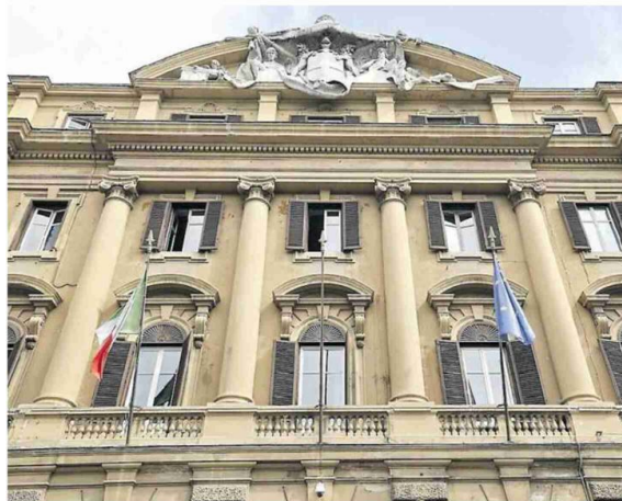
La facciata del palazzo dove ha sede il ministero dell'Economia in via XX settembre a Roma
