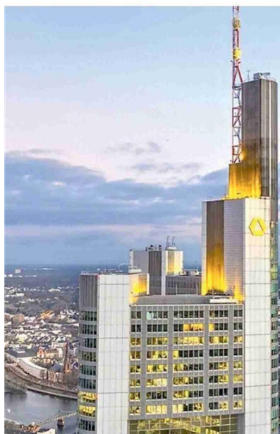
La Commerzbank Tower di Francoforte
