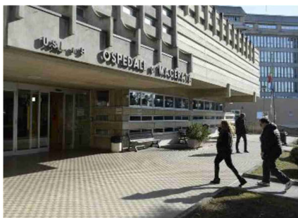
L'ingresso dell'ospedale di Macerata (foto Calavita)
