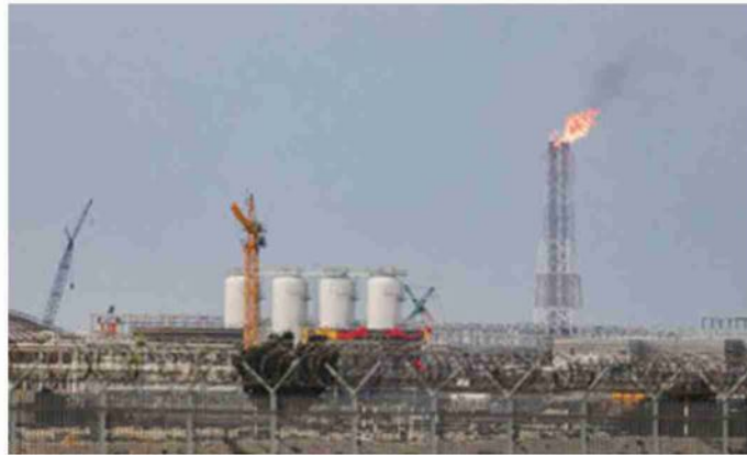
L'impianto qatarino di Ras Laffan foto Ap
