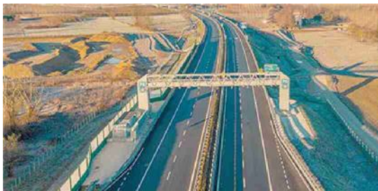
L'opera. Vista aerea dell'autostrada A33 Asti Cuneo
