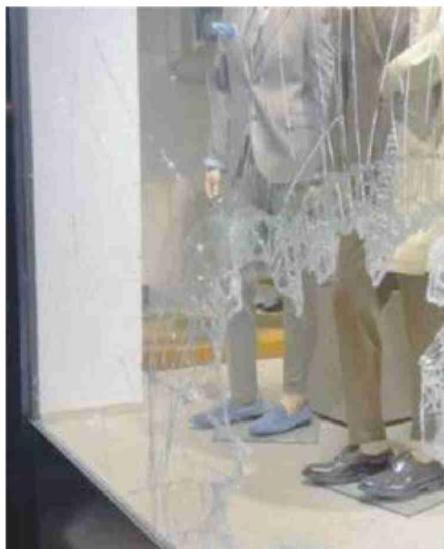
La vetrata sfondata dai ladri
