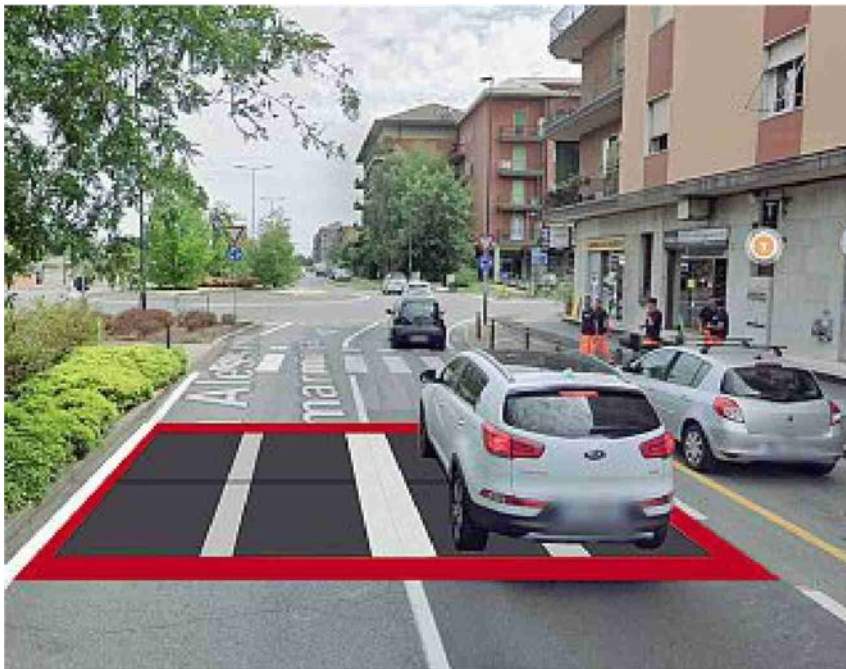
A filo d'asfalto La pedana (in rosso) cattura l'energia cinetica delle auto e la fa diventare energia
