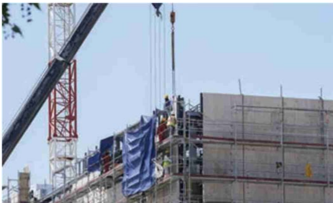
Operai al lavoro nel cantiere del Consolato Usa a Milano foto LaPresse
