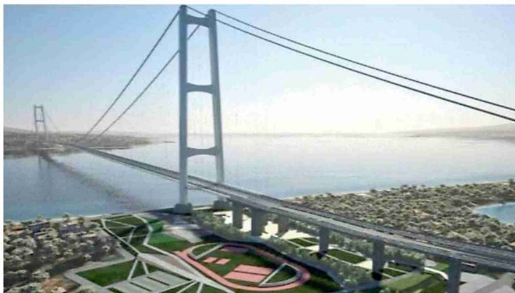
L'ambizione Il progetto dell'infrastruttura sullo Stretto di Messina prevede la costruzione del ponte sospeso più lungo al mondo, con una lunghezza totale di quasi quattro chilometri
