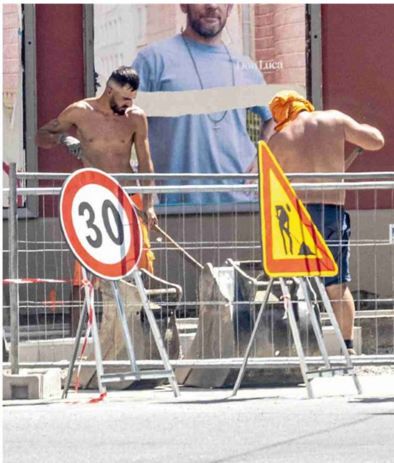
Operai al lavoro in strada a Torino
