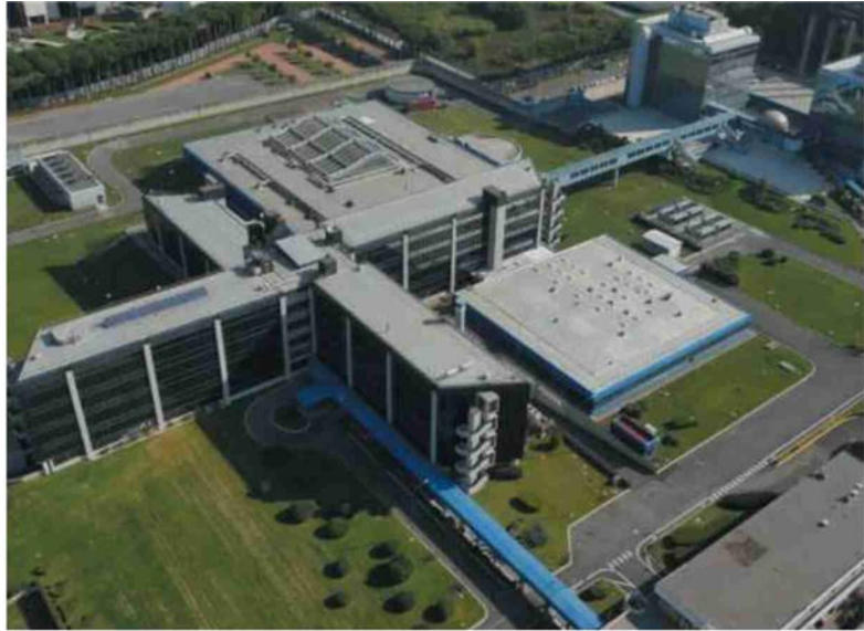
La sede della Sogei vista dall'alto
