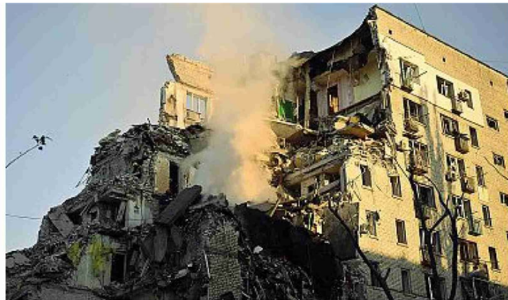
Distruzione Un edificio squarciato dall'esplosione causata dal raid scatenato dai russi ieri sulla capitale (Epa)
